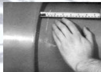
Vérification de l'emboîtement
