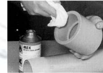
Nettoyer au décapant MEK tube & raccord
