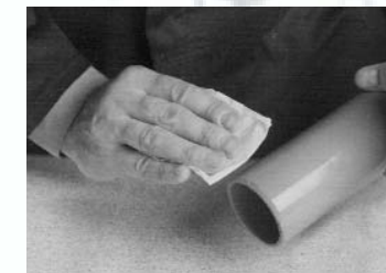
Dégraissier avec le décapant Eco
