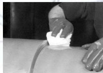
Essuyer l'excès de colle avec un chiffon propre
