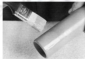
Appliquer la colle sur les tubes de 75 mm et plus
