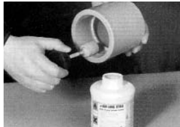
Appliquer la colle dans le raccord
