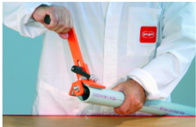
Foto 3: Smussatura del tubo Chamfering of the pipe Chanfrein du tube Anfasen des Rohres
