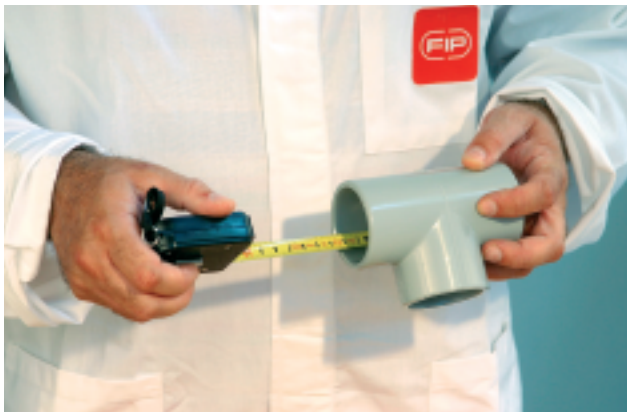
Foto 4: Misura della profondità del calettamento del raccordo. Measurement of fitting cylindrical sockets length. Mesurage de la profondeur du raccord. Messung vor der Klebunghres.
