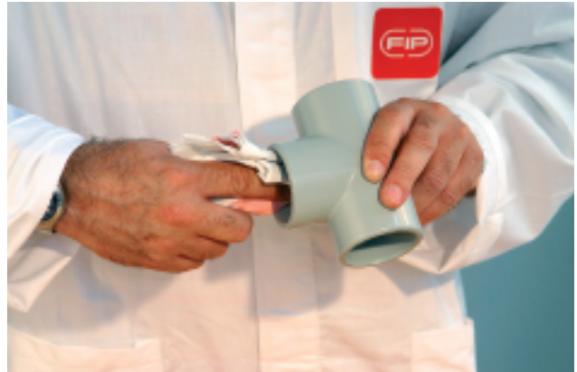
Photo 6 - 7 : Nettoyage du tube et du raccord en utilisant le Détergent-Primer TemperFIP
