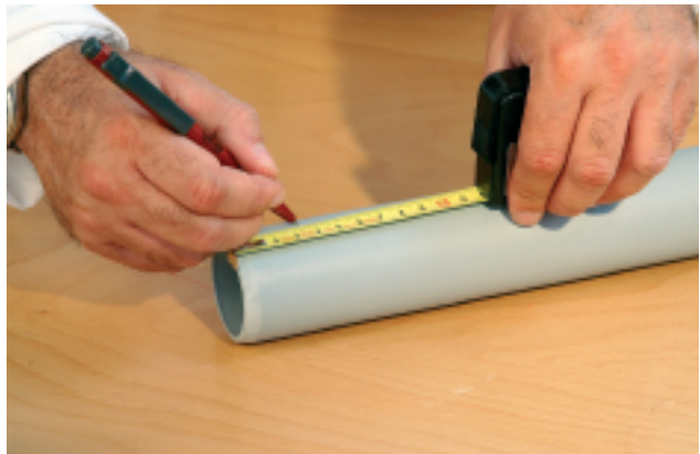
Foto 5: Lunghezza di inserzione del tubo. Switching length of the pipe. Longueur d'insertion du tube. Einstecktiefe des Fitting.
